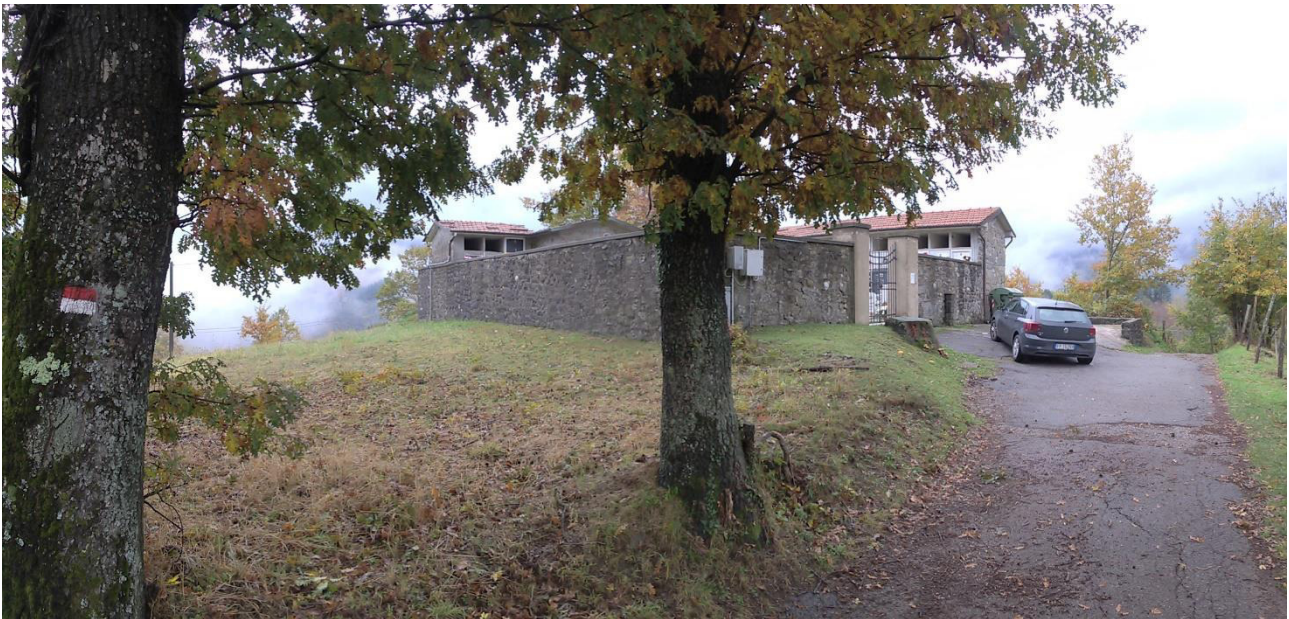
Foto 1. Vista esterna dalla strada di accesso
