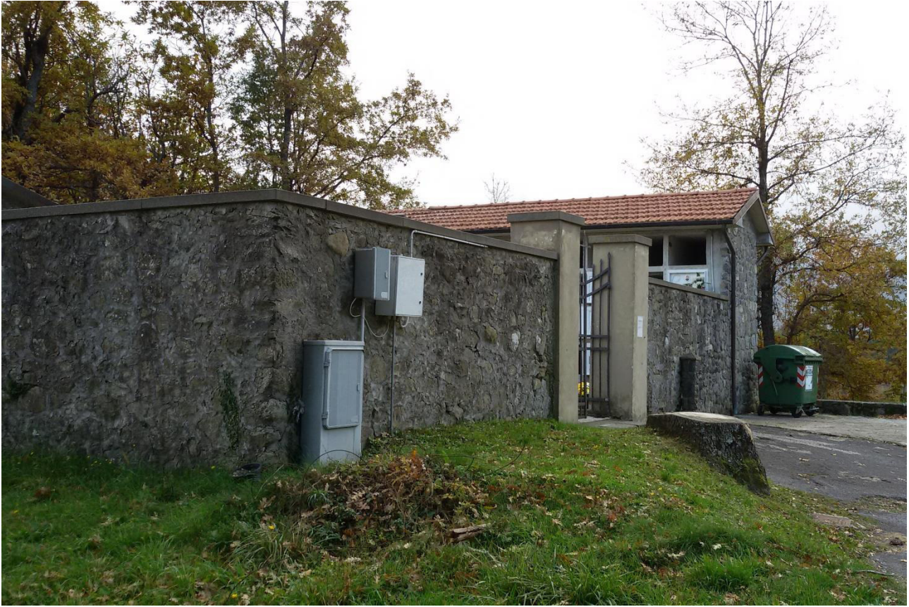
Foto 3. Cannello di ingresso
